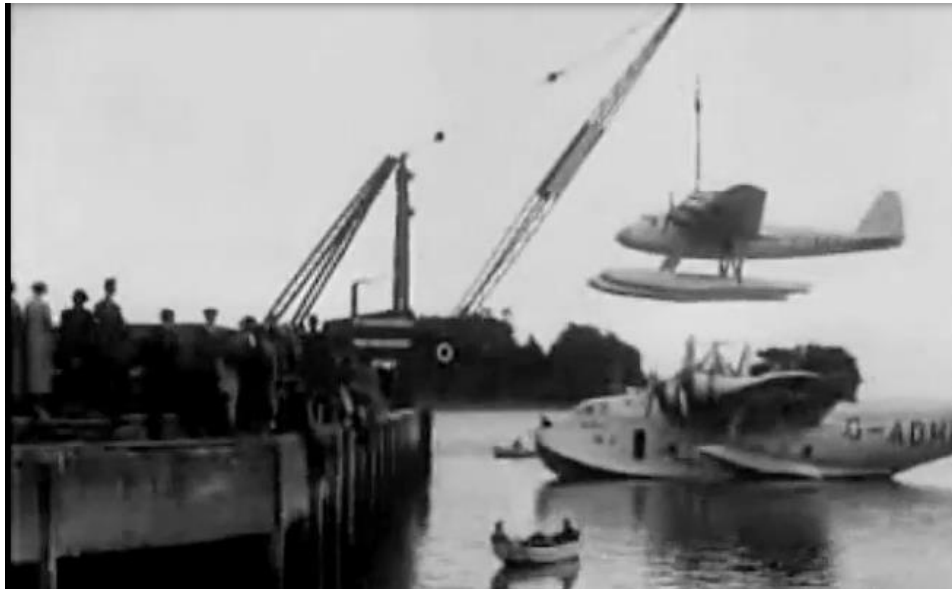
Acoplamiento del "mercury" sobre el "maia" por medio de grúa
